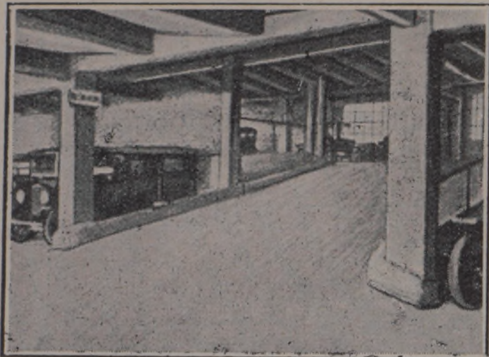
Fig. IV. — Le système Humy Motorramp : Vue prise du point A (voir fig. V). Lorsque l'automobiliste va aborder la rampe, il a déjà une vue très nette de l'étage où elle aboutit.
