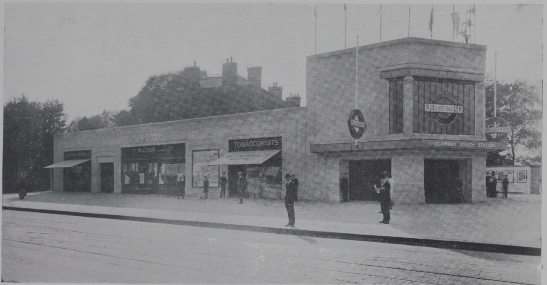
LES NOUVELLES GARES DE METRO A LONDRES L'ARRET DE CLAPHAM SOUTH PAR ADAMS, HOLDEN ET PEARSON
