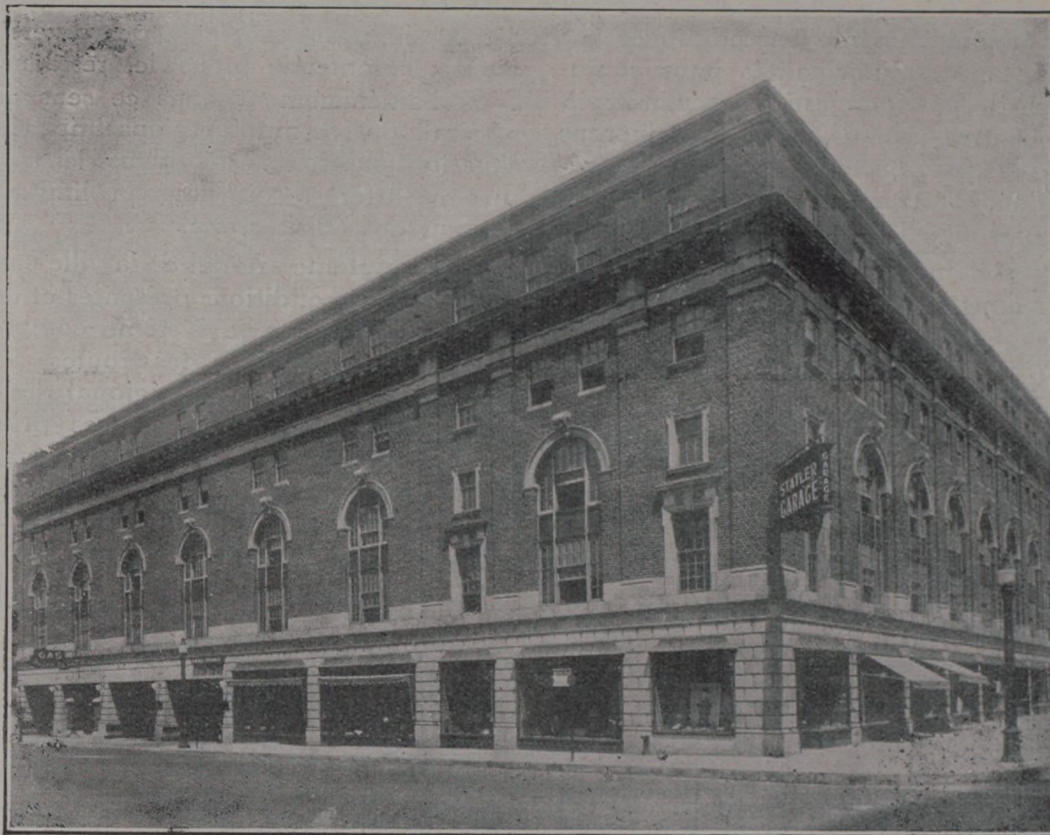
Fig. X. — Le Statler Garage de Philadelphie. — Voici la façade principale d'un garage établi d'après le système Humy. La rampe est placée dans un angle comme l'indique la figure VII (figurines 2 et 6). Cette disposition permet de sauvegarder la belle ordonnance des façades.
